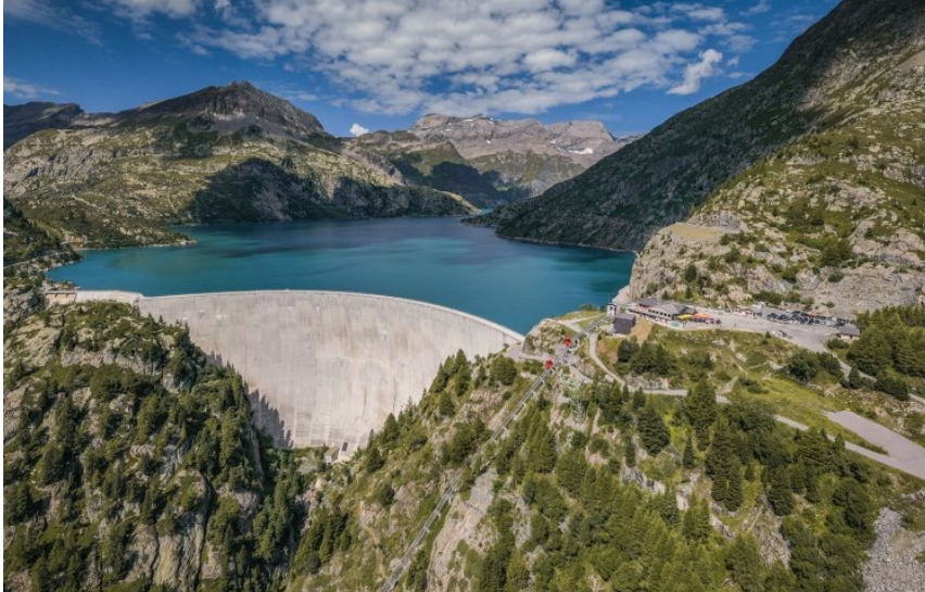
Staumauer und Stausee Emosson. https://www.valleedutrient.ch/fr/visite-guideee-du-barrage-d-emosson-fp591 ; 20.11.2022.
